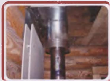
Соблюдать нормы противопожарной разделки (отступки) от горючих конструкций
